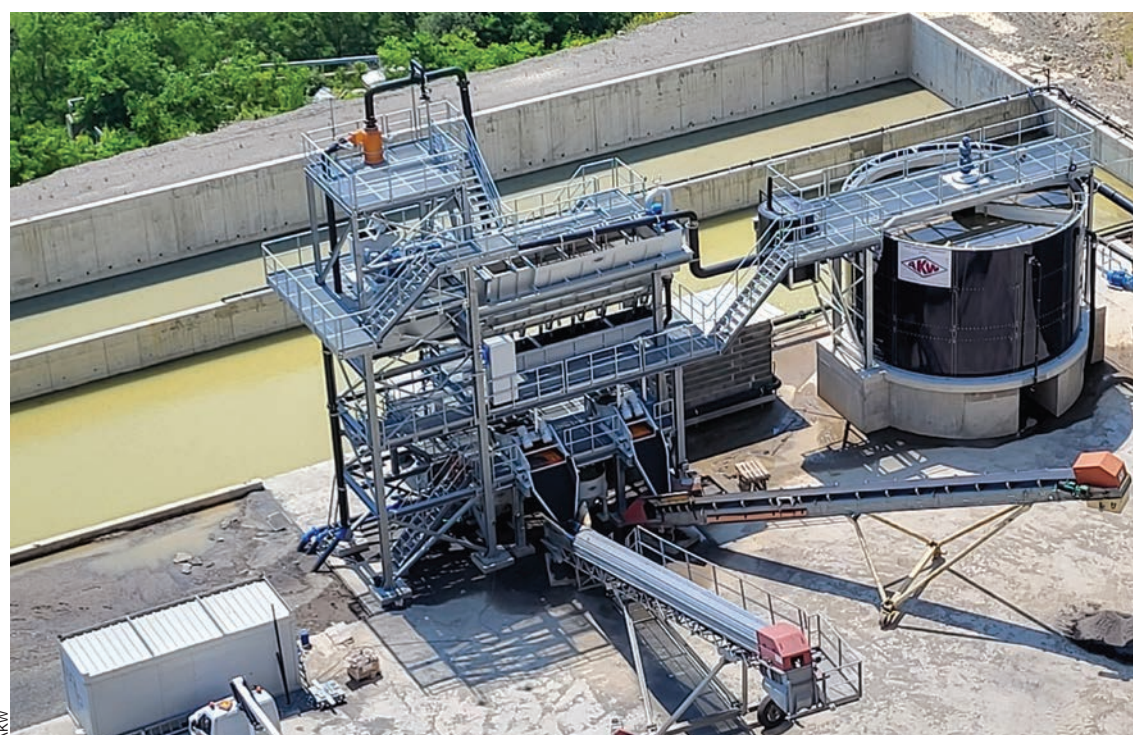
Unité de traitement et de valorisation des stériles et du tout-venant en carrière réalisée par AKW, en France.
